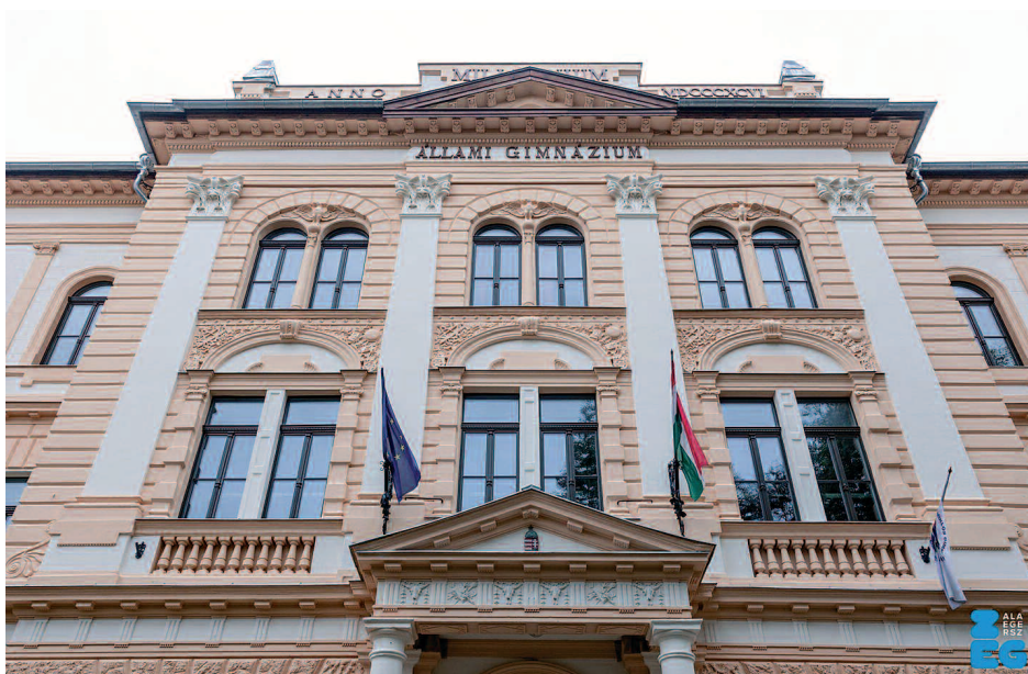
A gimnázium megújult homlokzata
